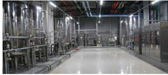
用于水净化和浓水回收的去离子水装置
